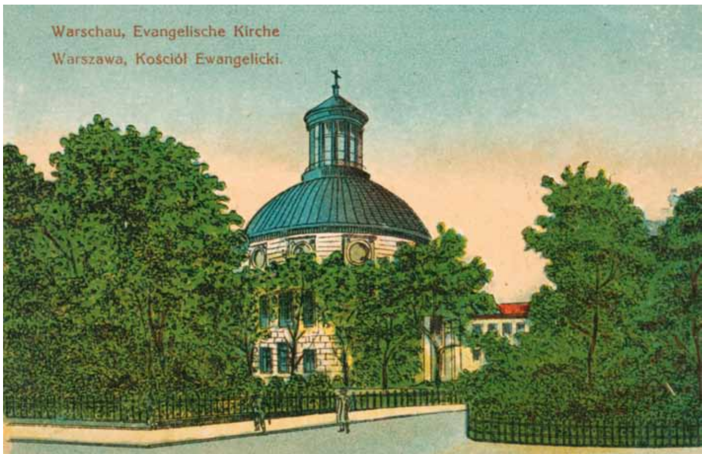
Abb. 7: Evangelisch-Augsburgische Dreifaltigkeitskirche in Warschau; nach Privileg von Stanisław August durch Simon Gottlieb Zug (Szymon Bogumił Zug, 1733–1808) zwischen 1777 und 1781 errichtet. Im Zweiten Weltkrieg ausgebrannt, 1949–1957 wiederaufgebaut. Die deutlich repräsentativere und auch das Warschauer Stadtbild prägende Kirchengestalt zeigt, dass seit den 1770er Jahren Lutheraner im öffentlichen Leben Polens stärker hervortreten konnten.
