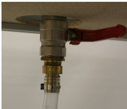
Abbildung 52: Darstellung des Anschlusses der Schlauchleitung (links) beziehungsweise der Druckrohrleitung (rechts) an den Kugelhahn
