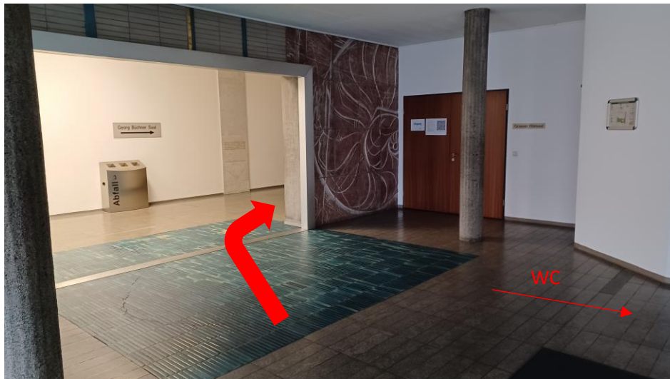
Abbildung 2. Eingangsbereich der Alten Universitätsbibliothek
