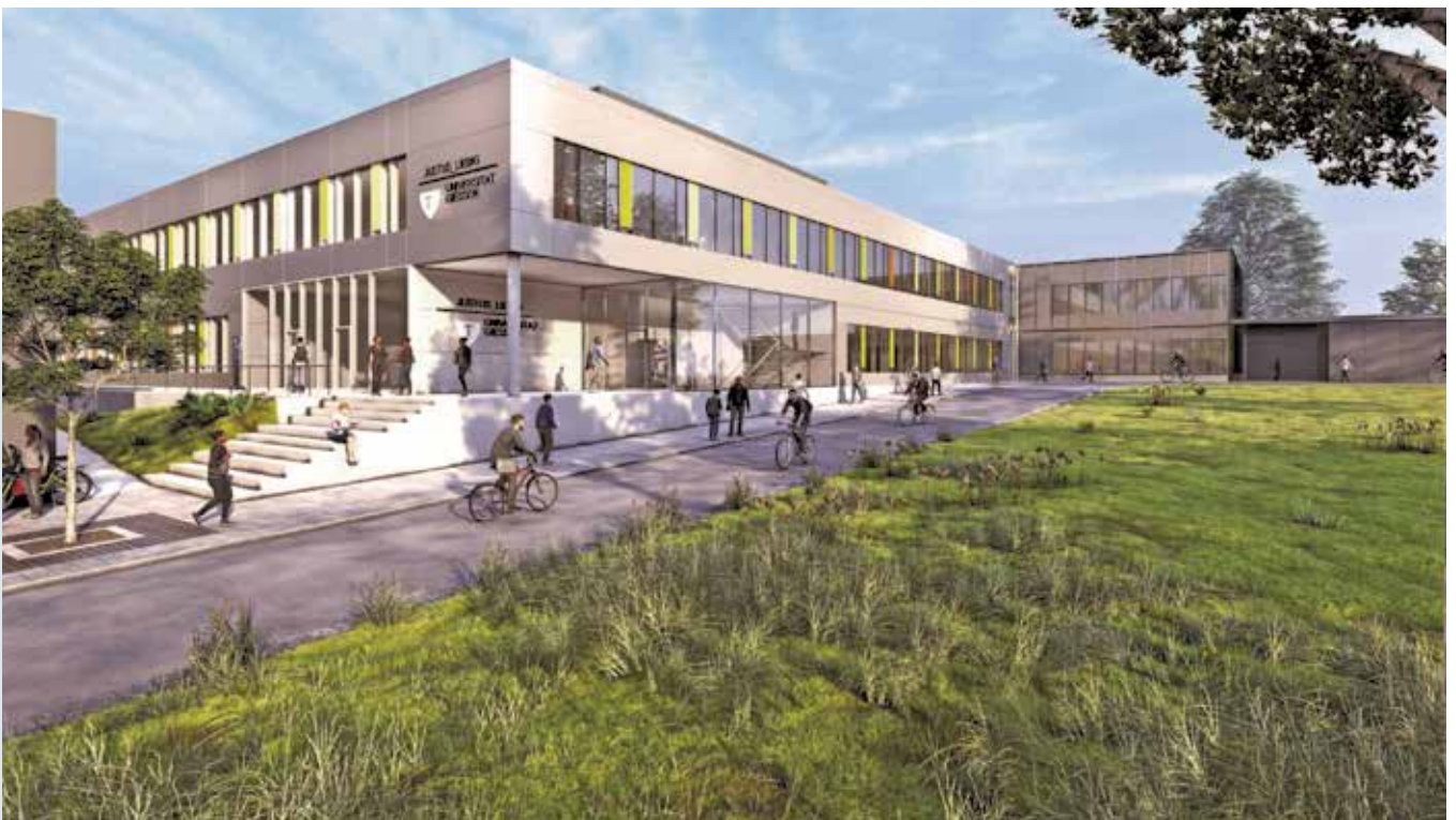
Am Campus Natur- und Lebenswissenschaften im Bereich Seltersberg entsteht bis Ende 2026 der Neubau CC-EIMaR.
