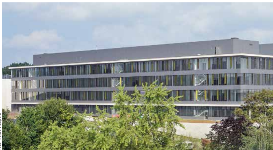
Positives Jahresergebnis 2013: Auch zahlreiche Neubauten – hier der nahezu fertiggestellte Neubau Chemie – fallen in die Haushaltsplanung.
