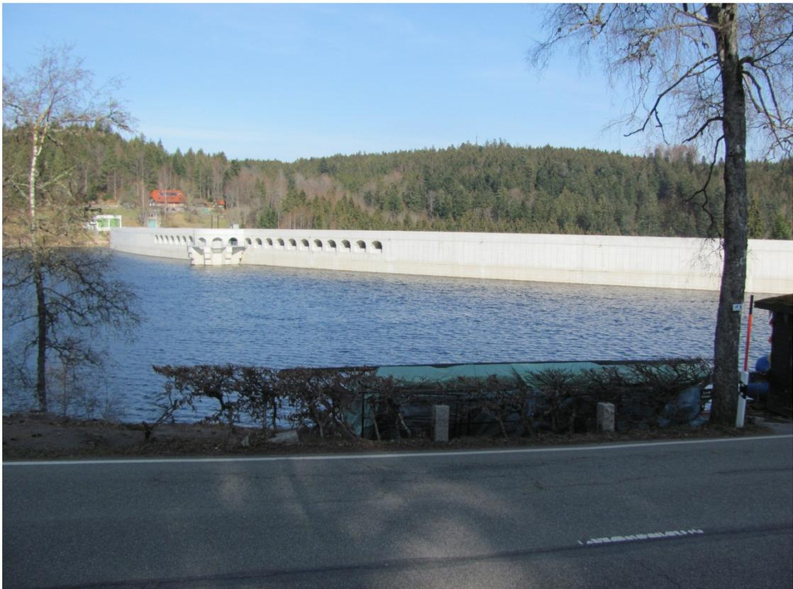
Blick auf die beeindruckende Staumauer der Schwarzenbach-Talsperre. Die Schwarzenbach-Talsperre ist das Oberbecken des Pumpspeicher-Kraftwerkes „Rudolf Fettweis“ der EnBW. Das Maschinenhaus befindet sich in Forbach, unmittelbar an der Murg. Der Höhenunterschied zwischen der Talsperre und dem Maschinenhaus beträgt ca. 350 m.
