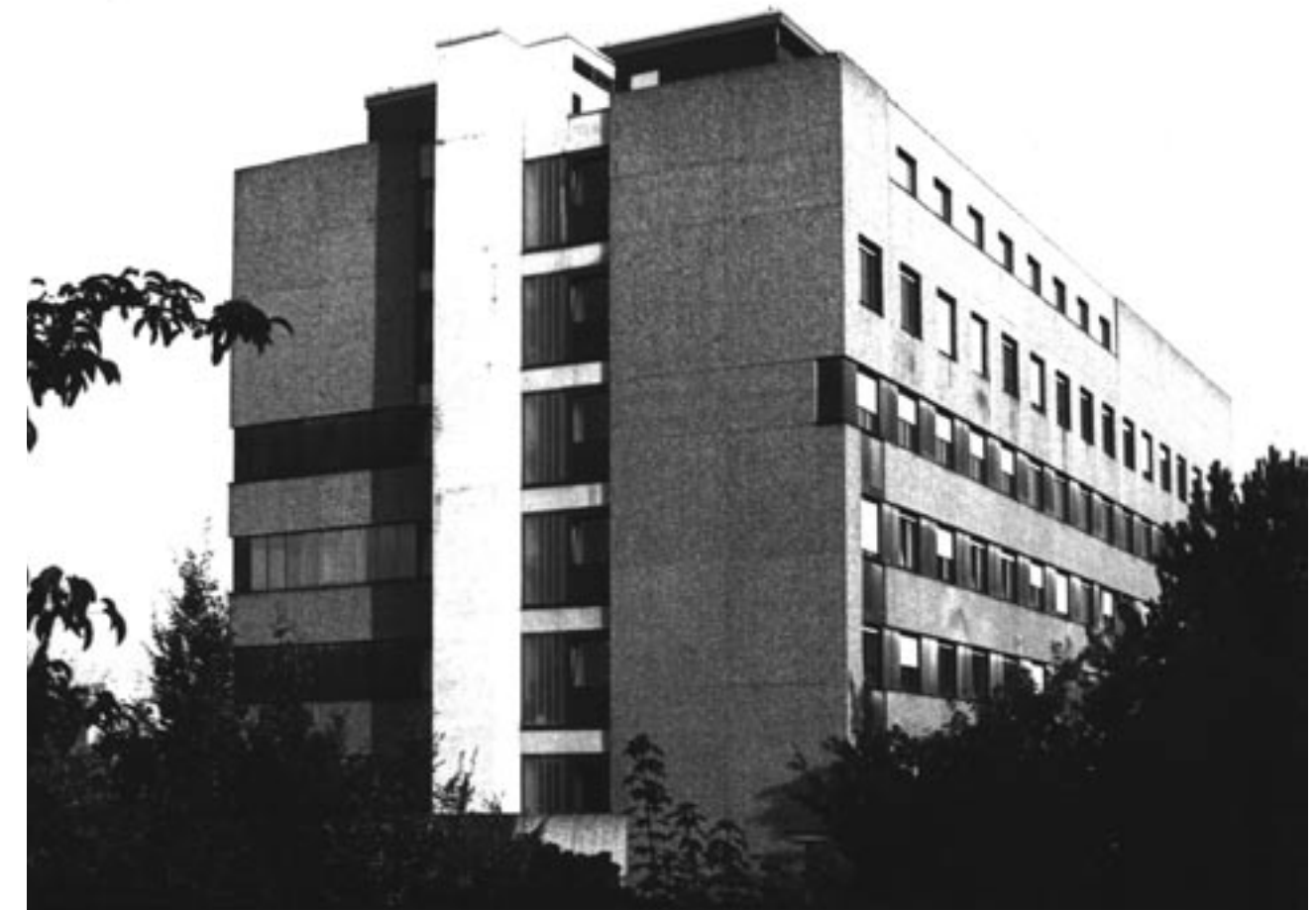
Abb. 3: Das 1973 bezogene Institutsgebäude
