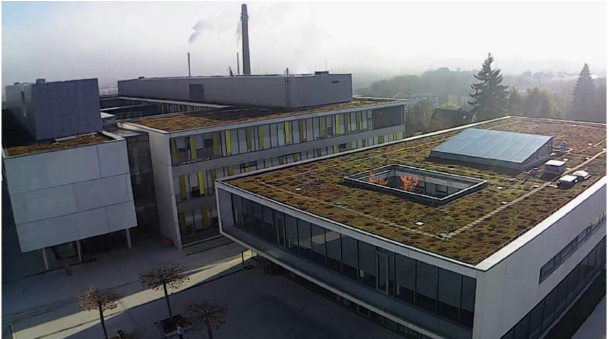
Abb. 21: Die neuen Chemiegebäude, vor welchen der zweite Start stattgefunden hat.
