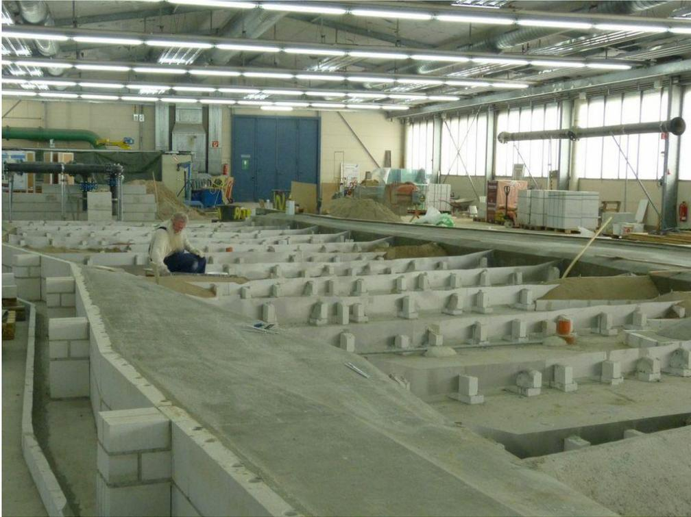
Führung durch die Bundesanstalt für Wasserbau in Karlsruhe. In einer der großen Hallen entsteht zurzeit ein neues Flussmodell. Die Bauplan-Vorgaben der Wasserbau-Ingenieure müssen exakt umgesetzt werden, um die späteren Testläufe und Modellierungen erfolgreich durchführen zu können.
