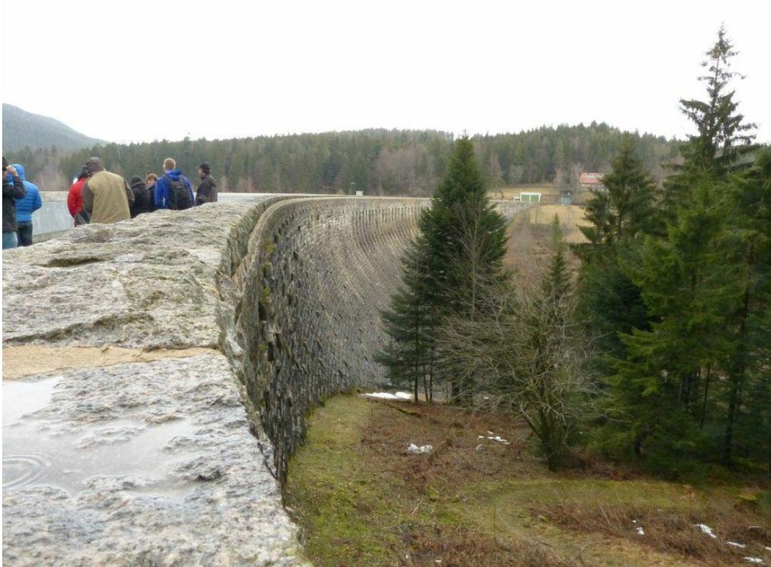
Die Exkursionsgruppe auf der Staumauer der Schwarzenbach-Talsperre (TK 50 L7314 Baden-Baden). Der so aufgestaute See ist eines der Oberbecken des Pumpspeicherkraftwerks „Rudolf Fettweis“. Das zugehörige Krafthaus mit Francis- und Kaplan-turbinen befindet sich am südlichen Ortsausgang von Forbach im Murgtal. Das mittlere Nutzgefälle beträgt 357 m.
