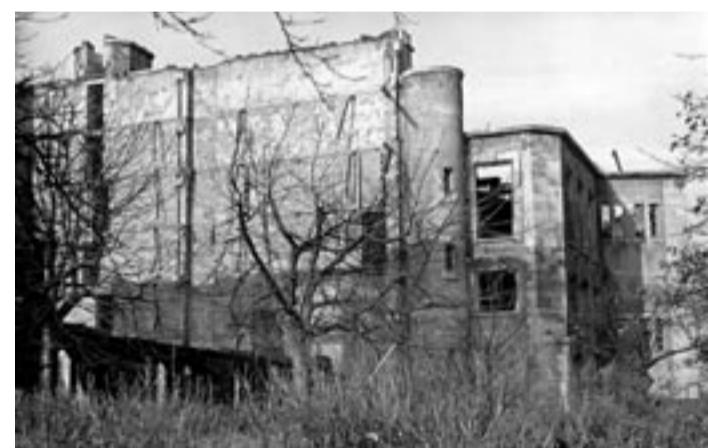
Raub der Flammen: Nach dem Brand konnte das Gebäude der Universitätsbibliothek nicht mehr betreten werden.
