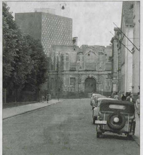
Hinter den Ruinen der alten Universitätsbibliothek ragt das Hochhaus des Neubaus von 1959 hervor.
