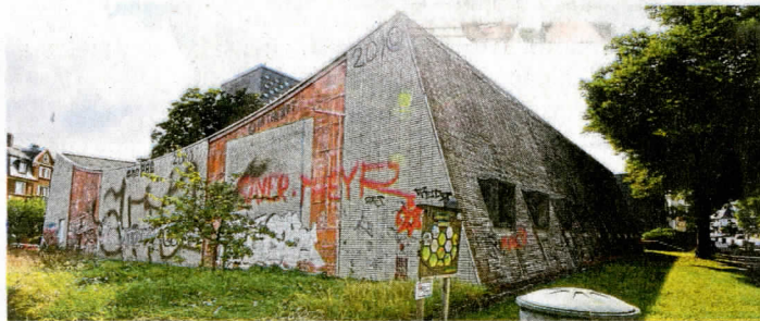
Das Gebäude in der Bismarckstraße 37 ist marode.
