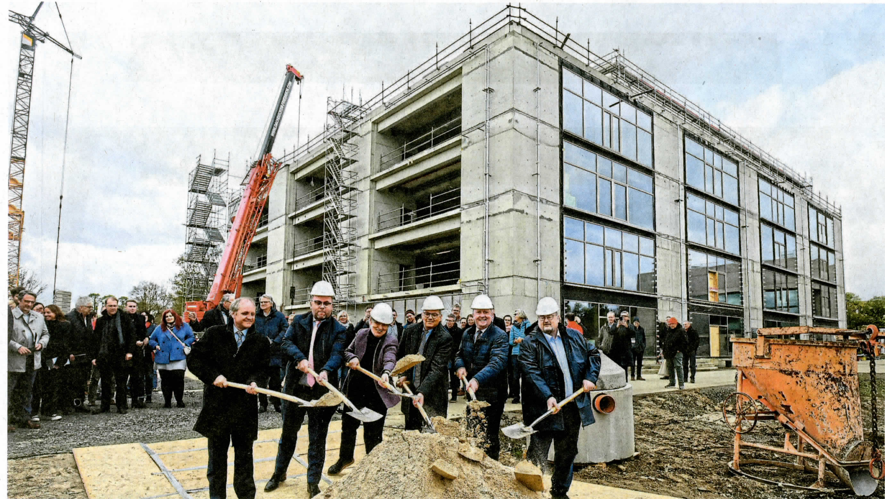
Mit dem Spatenstich wird der Neubau des Seminargebäudes eingeläutet. Der Bau der Bibliothek hingegen ist schon deutlich weiter fortgeschritten.
