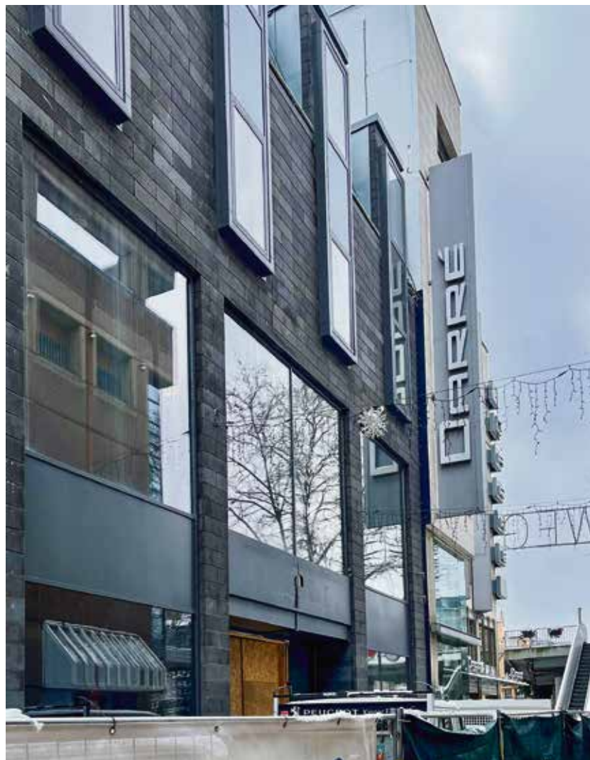
Große Glasfronten und gute Erreichbarkeit: die neue Heimat der Zweigbibliothek Natur- und Lebenswissenschaften.
