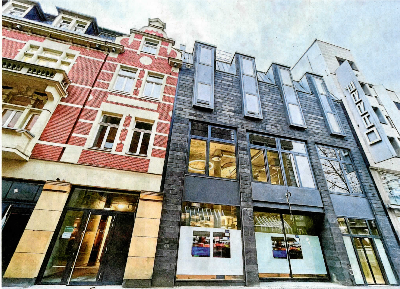
Am 1. April soll das Gebäudeensemble im Seltersweg in Betrieb gehen.
