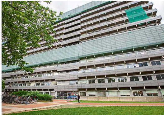
Nur bei Tageslicht offen: In dem Gebäude ist die Sicherheitsbeleuchtung kaputt. Foto: Mosel
